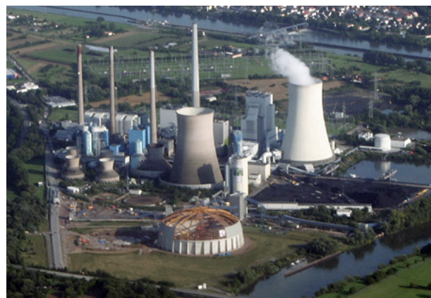
Figura 51: Geração de eletricidade por usinas de carvão reduzem significativamente os benefícios climáticos dos veículos elétricos: Usina a carvão em Hanau, Alemanha. Fonte: Dominik Schmid, 2009
